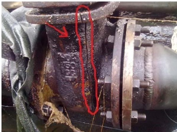
شکل ۱. ناحیه شکست Gate Valve
